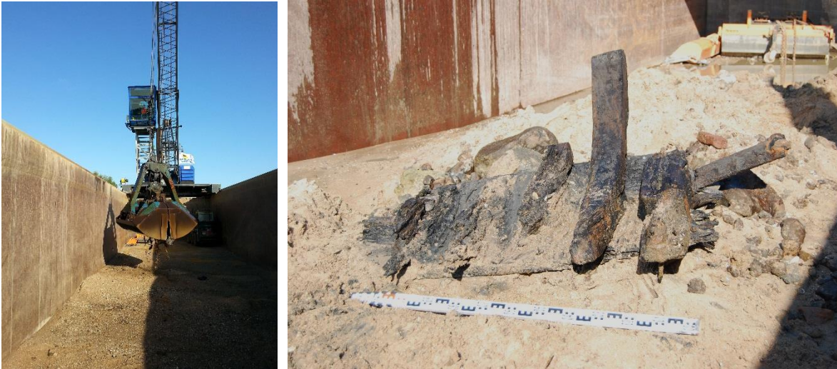
Afbeelding 55 Scheepshout wordt geborgen tijdens de archeologische begeleiding op de wraklocatie. Foto: Vestigia.
